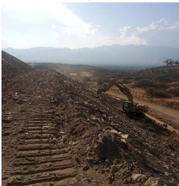
Reubicación de residuos sólidos para la conformación de las banquetas intermedias de las macro celdas 1 y 2.
