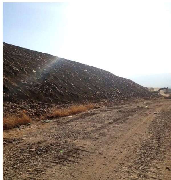
Afinado del talud intermedio de las macroceldas 1 y 2..
